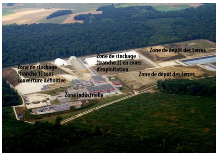
Vue aérienne du CIRES (Source : ANDRA).
