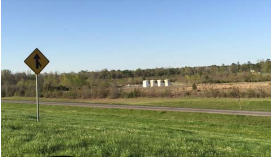
Des réservoirs isolés de collecte d'hydrocarbures
